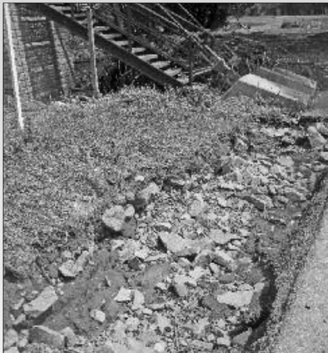
Aufräumen nach der Flut: hier wurde im Bereich der Schaukelbrücke auf der Biensdorfer Straße der Straßenkörper ausgewaschen. Bis zur Instandsetzung bleibt der Straßenabschnitt gesperrt.
